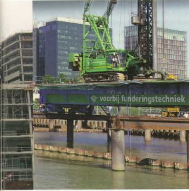
Op dit moment wordt nog hard gebouwd (doorzicht naar gebouw ABN-AMRO).
