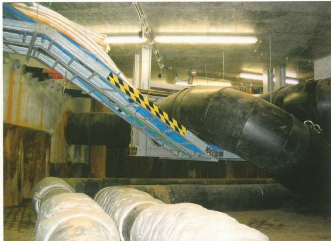
3 | De 'hamerkop': voor de aansluiting op het in de volle grond liggende kabel- en leidingwerk werden de uiteinden van de ILT verbreed
